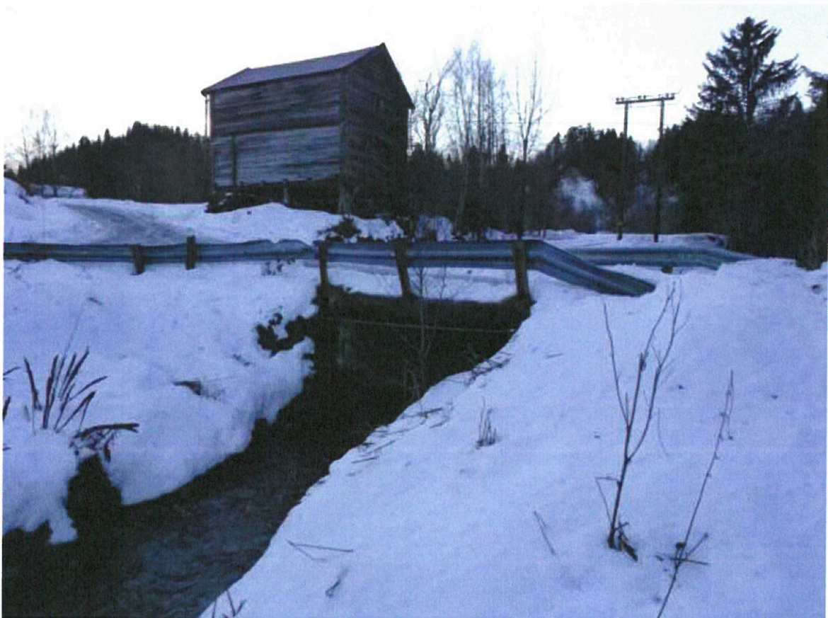
5b Moevegen bru 2
