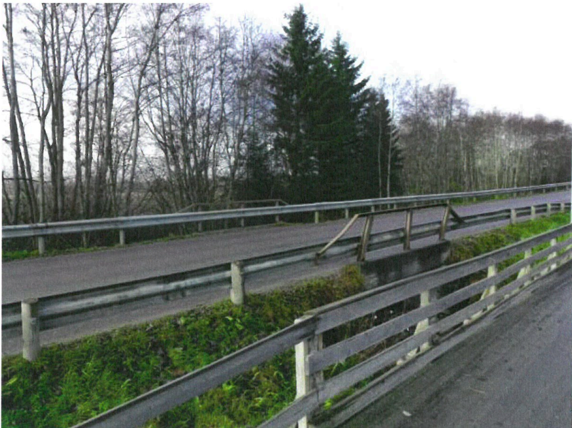
7b Evjen vegbru
