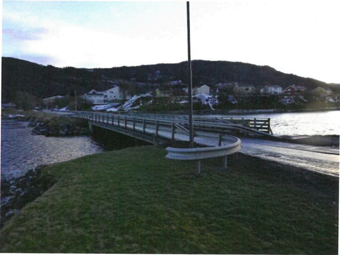
8a Havnevegen vegbru
