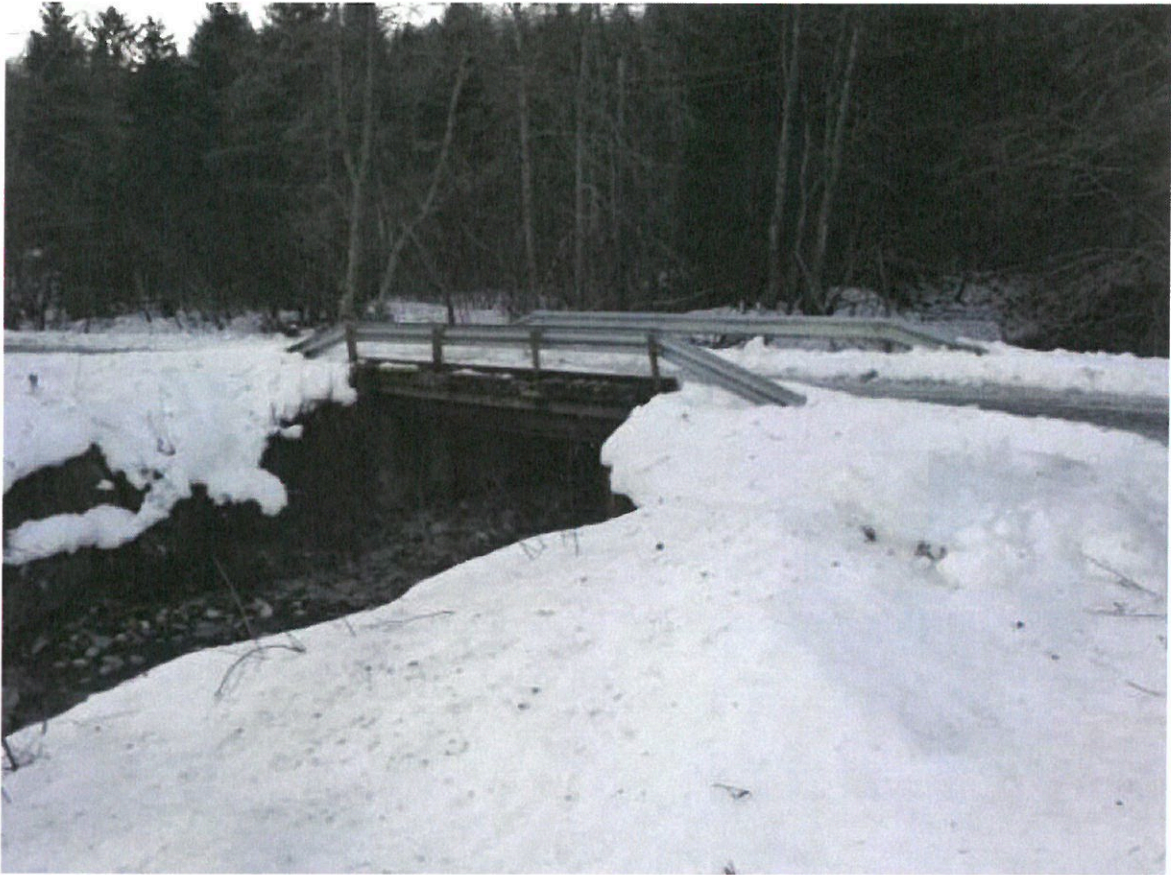
5a Moevegen bru 1
