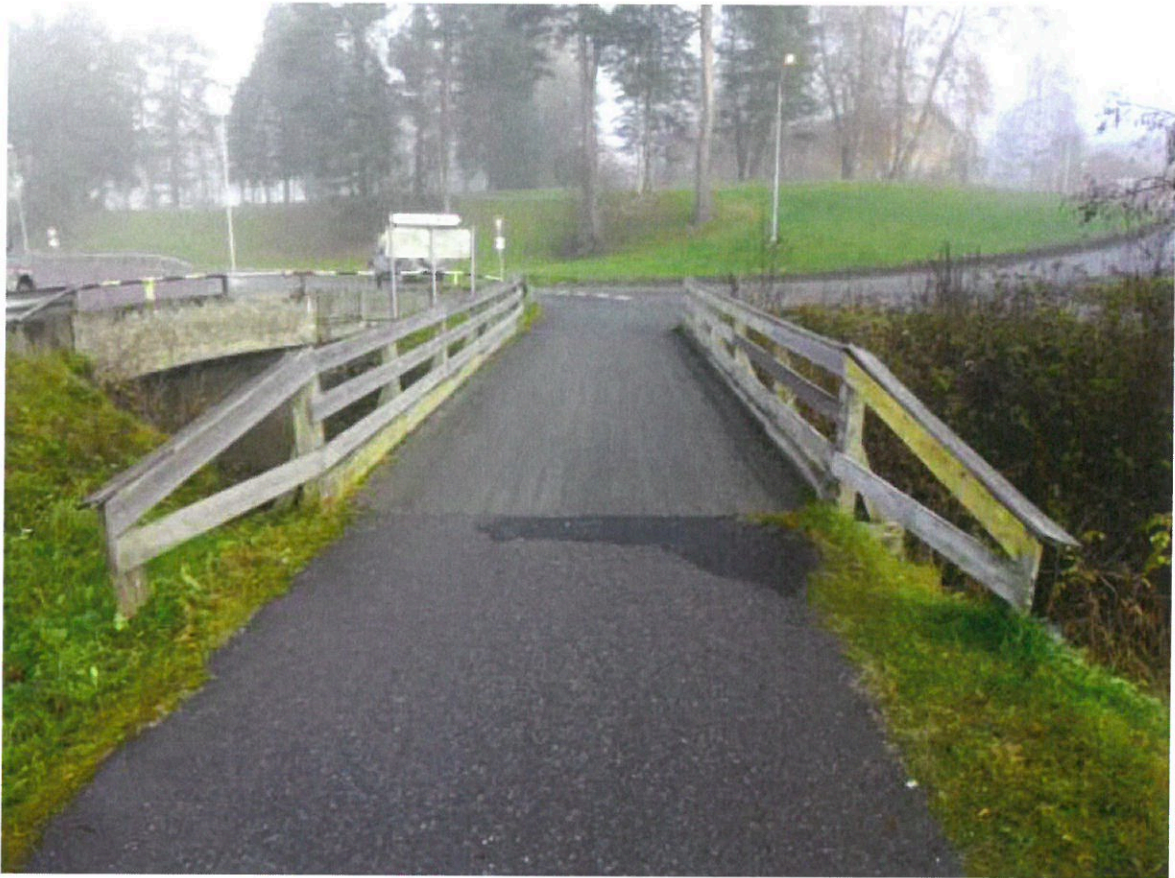
6a Follo gangbru
