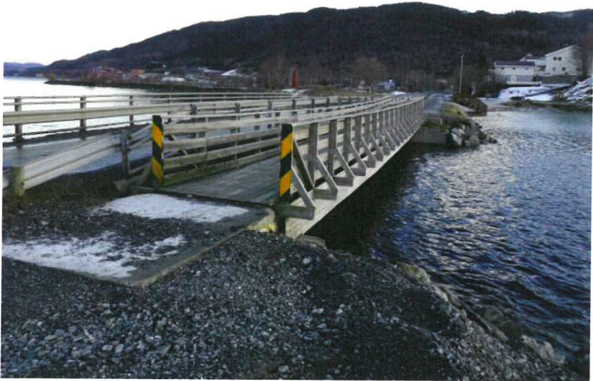
8b Havnevegen gangbru
