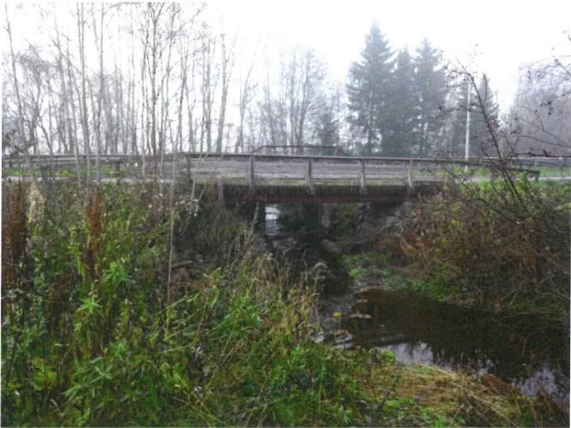
7a Evjen gangbru
