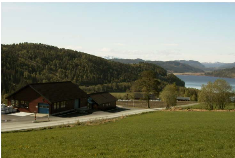
Fig. Songmoen vannbehandlingsanlegg.
