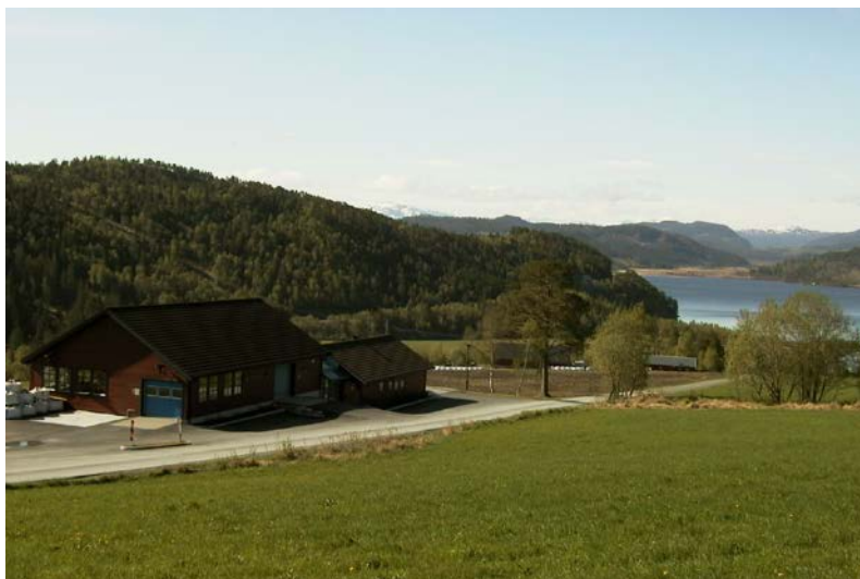
Fig. Songmoen vannbehandlingsanlegg.
