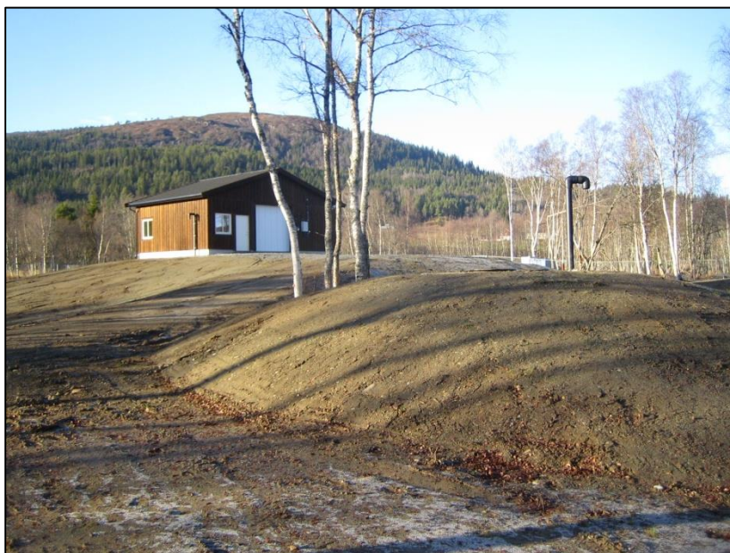
Fig. Pumpehuset på Dorøya.
