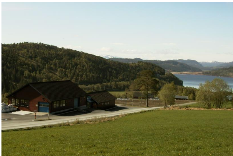
Fig. Songmoen vannbehandlingsanlegg.
