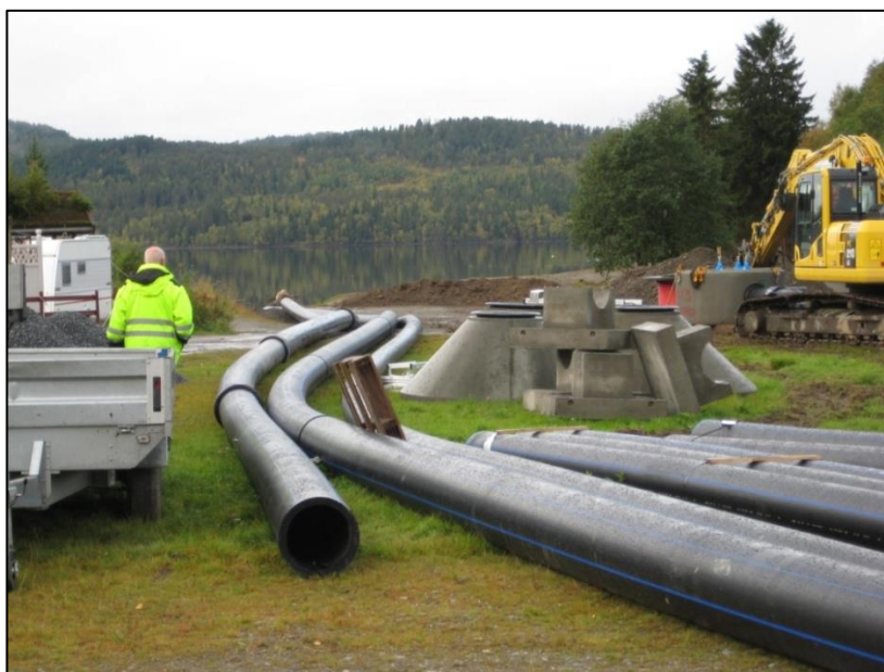
Fig. Anleggsarbeid ved Gangåsvatnet – ny overføringsledning fra Dorøya.
